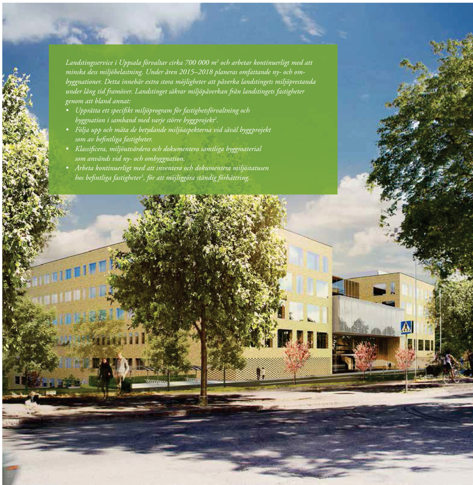
J-huset, Ingång 100, Akademiska sjukhuset – med miljöbyggnad, guld.
