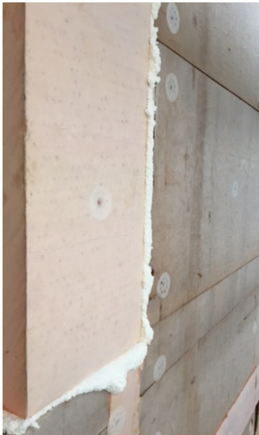
Bild 3. Åtgärdad isoleringsyta
