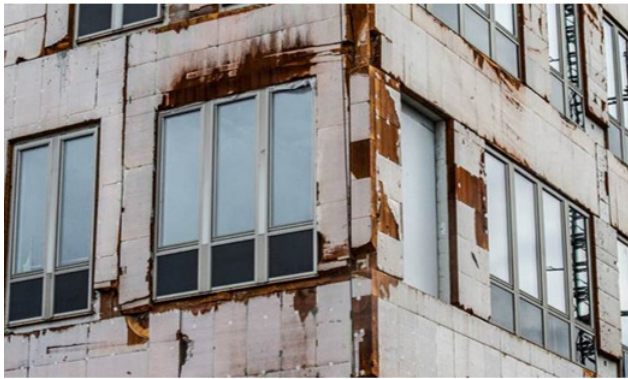
Bild 1. Missfärgad isolering
